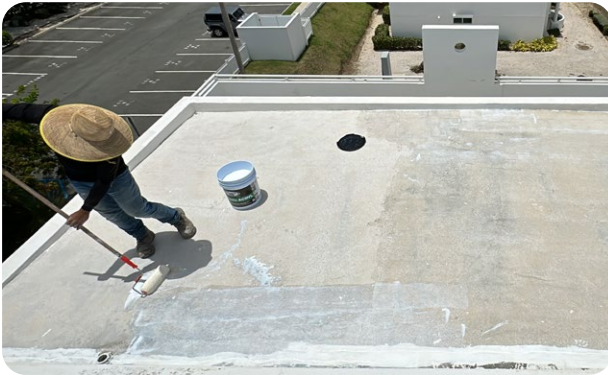
Aplicación de Elasto Acryl™ en techo de concreto.
