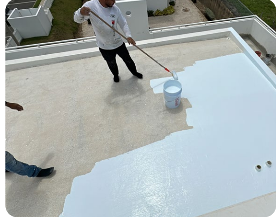
Aplicación de primera capa
