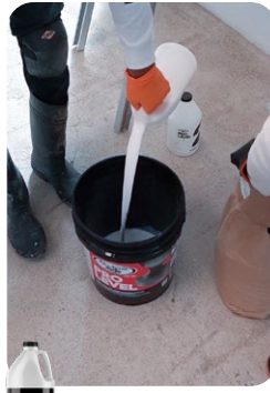
2 Paso 2 ½ gal Aditivo Latex
