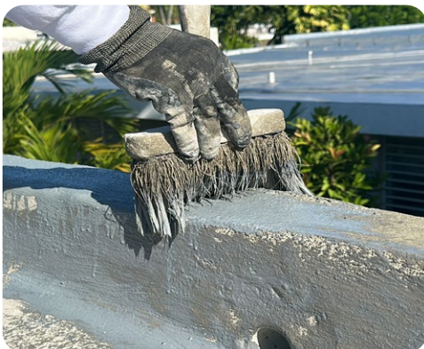
Aplicación de Sabakrete™ + Microtopping con brochon sobre petril.
