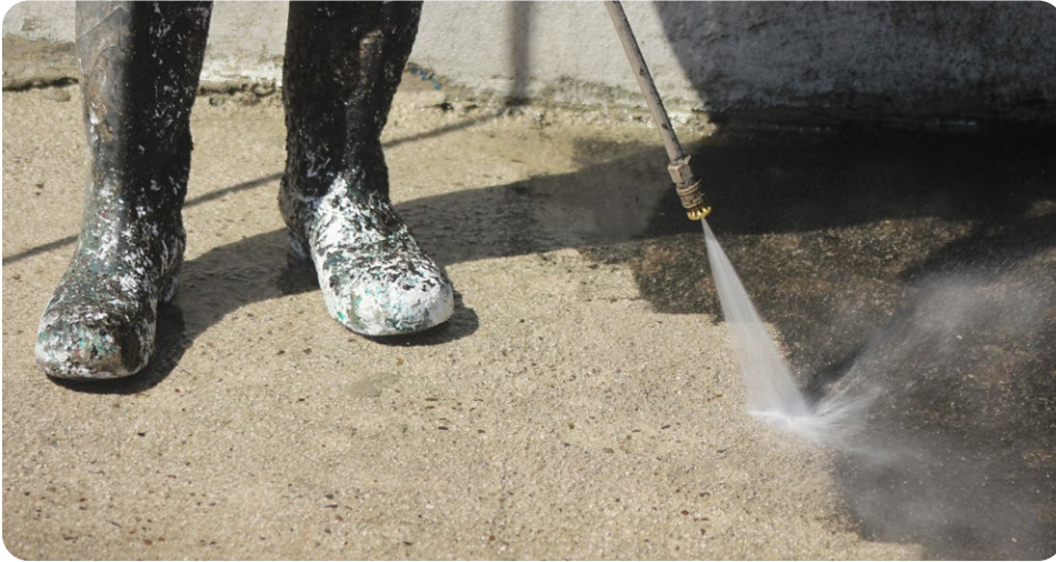
Lavado de Agua a Presión >3,000 PSI
