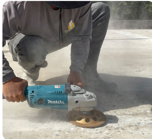
Remoción de brea con disco de desgaste
