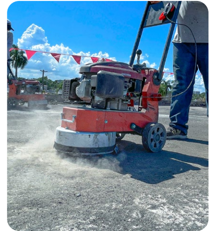
Preparación de superficie con devastadora
