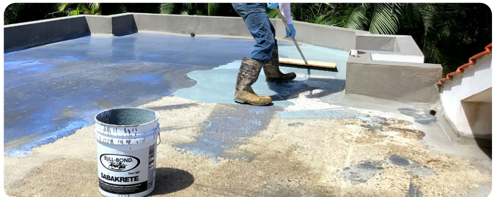
Aplicación con cepillo de Sabakrete™ + Micro-Topping para resanado en techo.
