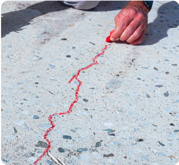
Identificar grietas >20 mils y marcar
