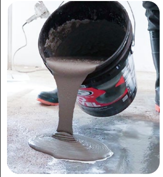
Vertido de Pro Level™ en el centro del empozamiento
