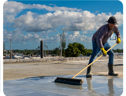
Aplicación con cepillo de Sabakrete™ + Micro-Topping para resanado en techo.
