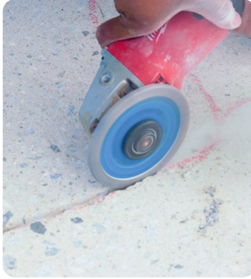
Realizar corte con disco de diamante de ¼ X ¼
