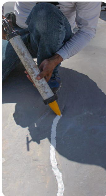
Aplicar sellante dentro del corte
