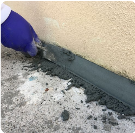
Creación de zabaleta (mezcla de Sabakrete™ y General Repair)
