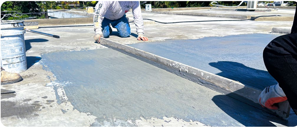
Nivelación de empozamiento con regla (mezcla de Sabakrete™ y General Repair)
