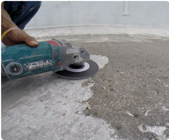
Remoción de sellador expirado con Disco Zec
