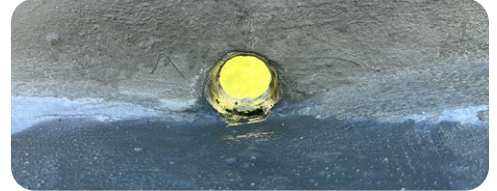
Reparación de drenajes (mezcla de Sabakrete™ y General Repair)
