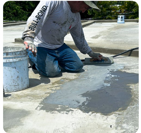
Alizado de mezcla con flota
