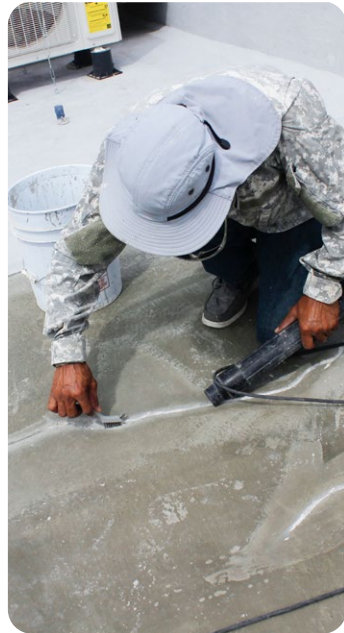
Limpieza con blower o compresor
