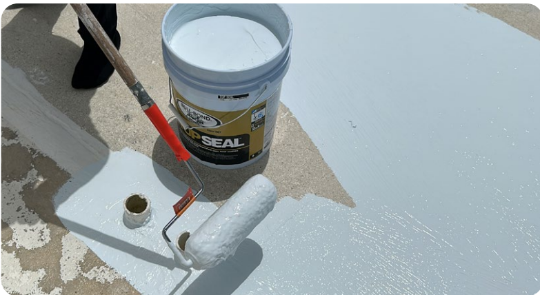
Aplicación de sellador en penetraciones.
